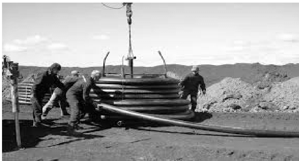
Рис. 1 -Размотка ПАСНТ из бухты для монтажа выкидного трубопровода
